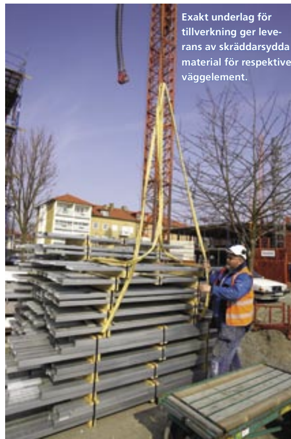
BPB Gyproc ska leverera totalt 2400 kvadratmeter yttervägg till de två punkthusen som byggs i centrala Trelleborg.
